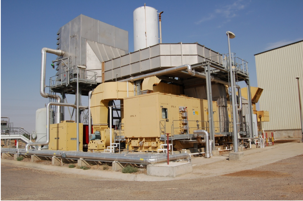
الشكل (1-2) : العنفة الغازية المختارة من نوع (Nuovo Pignone Frame 6)
