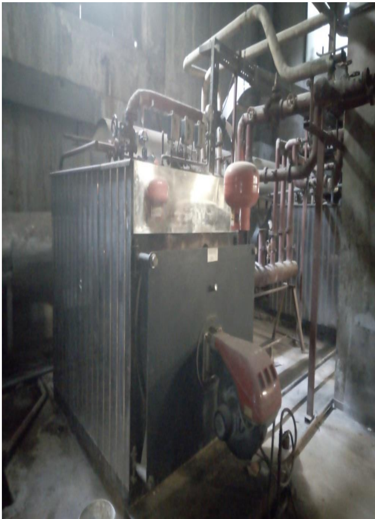
الشكل (2-6) المرجل الحراري في مشفى التوليد الجامعي
