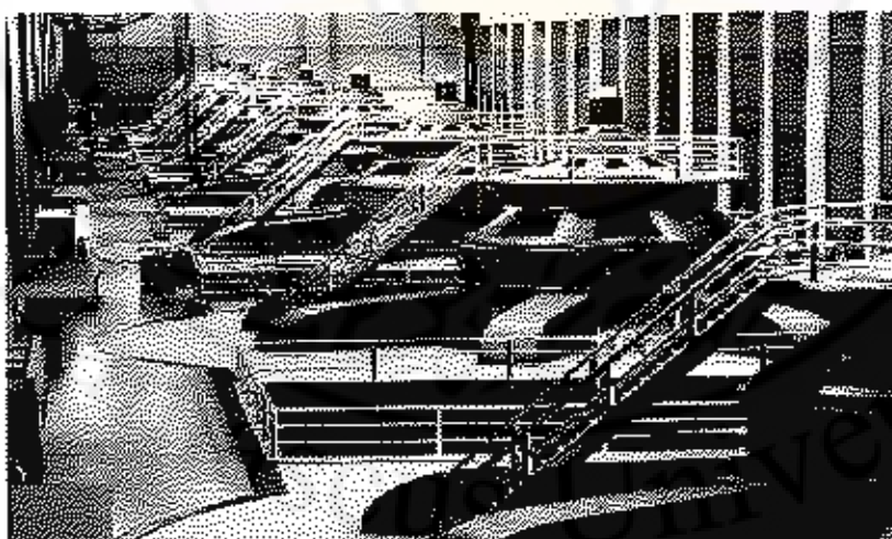
الشكل 12 - 3 صالة المولدات في المحطة الكهرومائية على سد هوفر [3]
