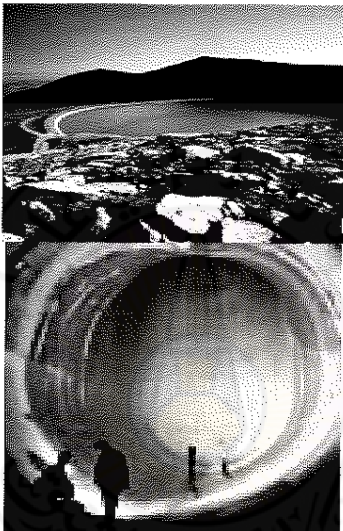
الشكل 12 - 12 حوض التخزين الأعلى و ونفق المياه الذي يمثل أنبوب السحب [4],[5],6[7]
