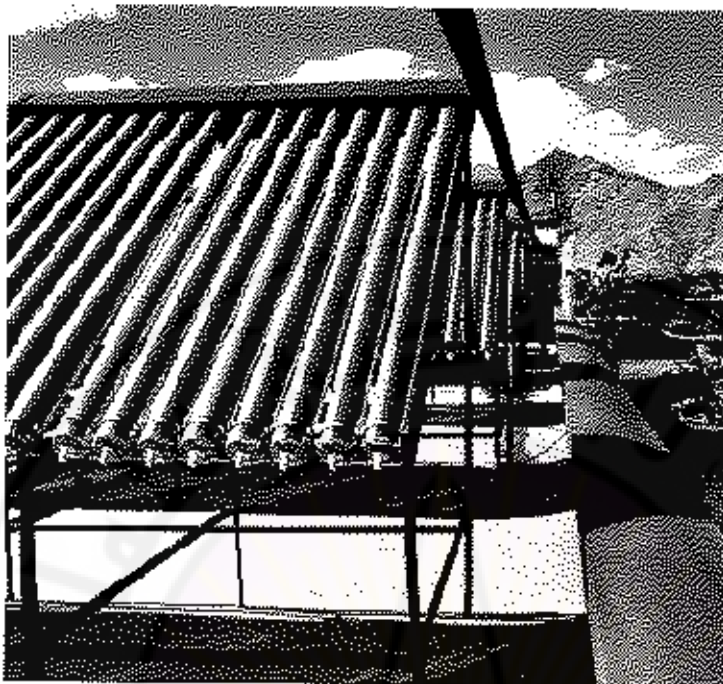
شكل 2-3: نظام تسخين شمسي ذو لواقظ ذات أسطوانات مفرغة مركبة في الصين
