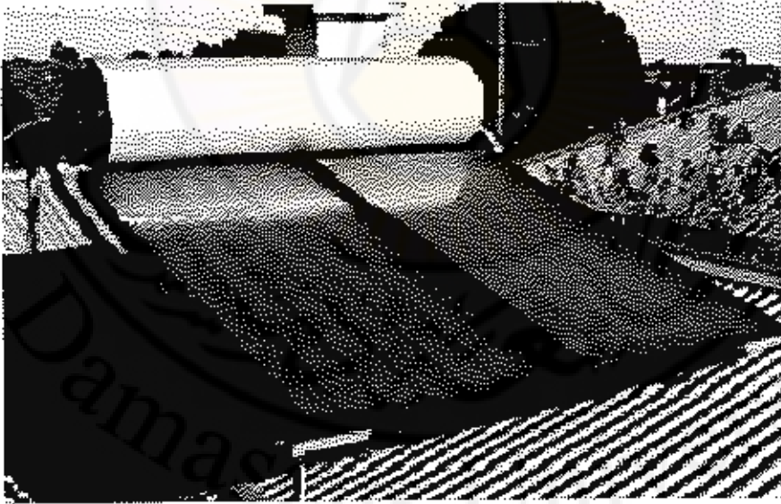
شكل 1-3: نظام تسخين شمسي ذو لواقط مسطحة ودوران طبيعي (ثيرموسيفوني)
