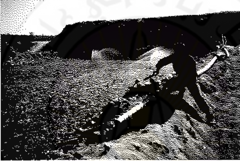
الشكل 11 - 27: معالجة الرشاحة عبر إعادة التدوير
