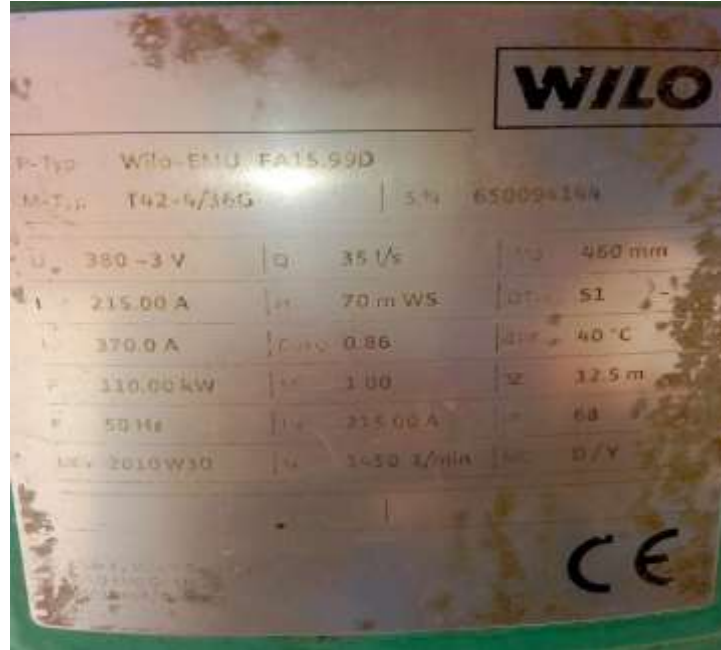
الشكل (23) : اللوحة الاسمية للمضخة المدروسة.
