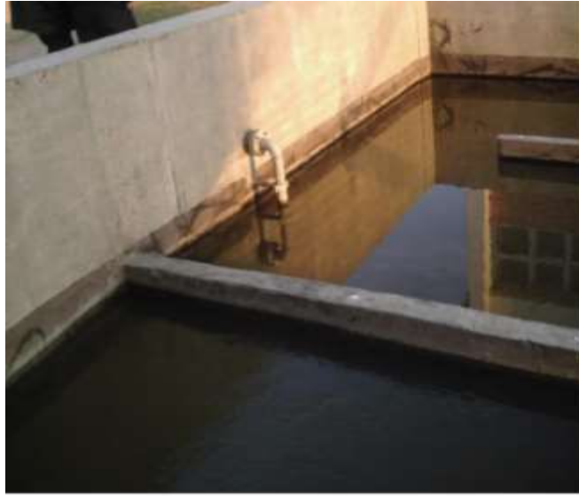
الشكل (11) متاهة التماس مع الكلور.
