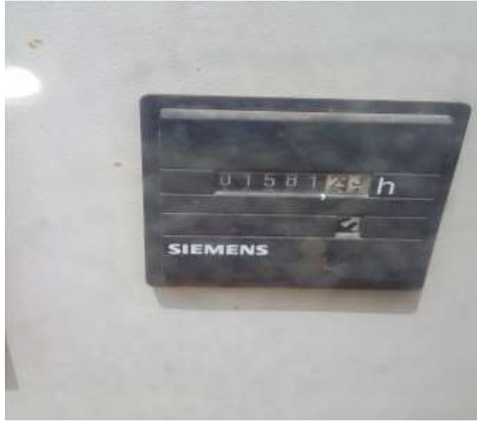
الشكل (22) : عداد ساعات التشغيل للمضخة.
