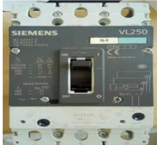
الشكل (20) القاطع العياري الرئيسي لمضخة 110 \text{ kw} .
