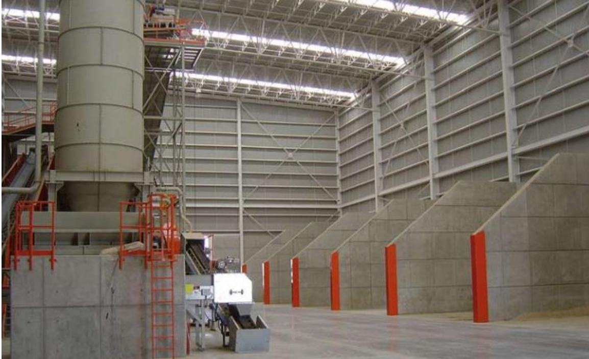
الشكل (1 - 3) الحجرات البيتونية التي يتم تخزين المواد الأولية ضمنها
