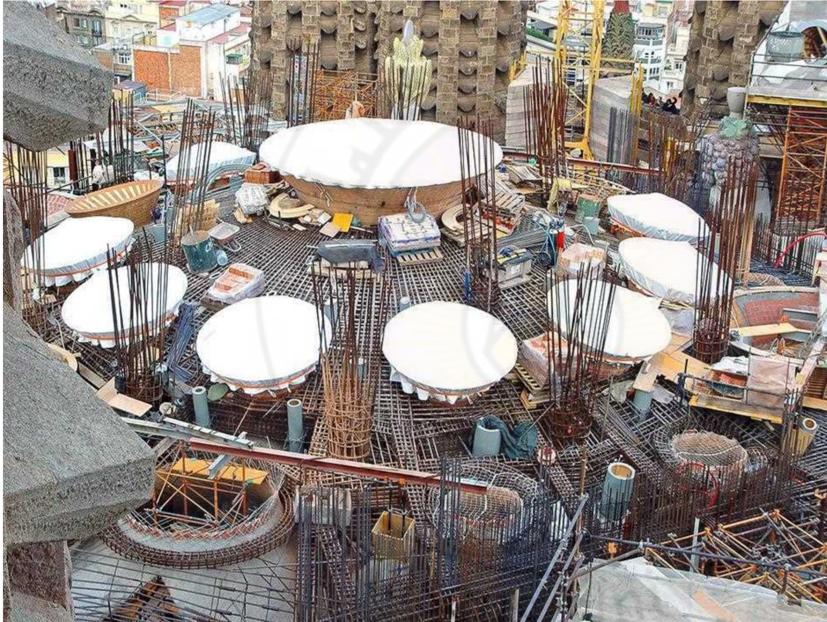
قاعدة برج المسيح قيد الإنشاء ( 2009 )
