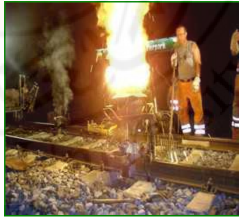
الشكل (3-44) اللحام بواسطة الترميت (الألوميني الحراري)
