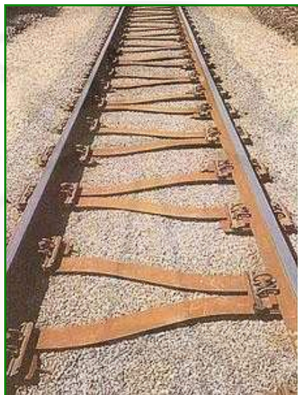
الشكل (16-3) العارضة المعدنية ذات الشكل Y
