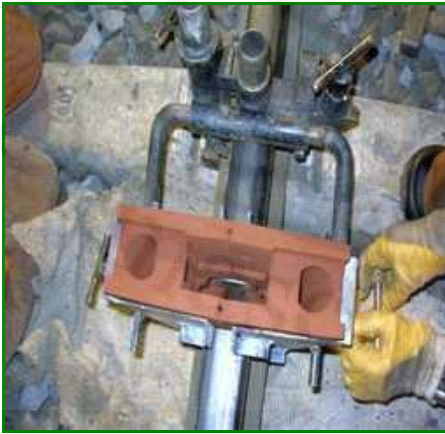
الشكل (3-44) اللحام بواسطة الترميت (الألوميني الحراري)
