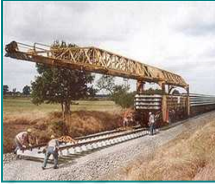
الشكل (1-8-b) آلة لإنشاء الخط الحديدي وآلة تبديل القضبان
