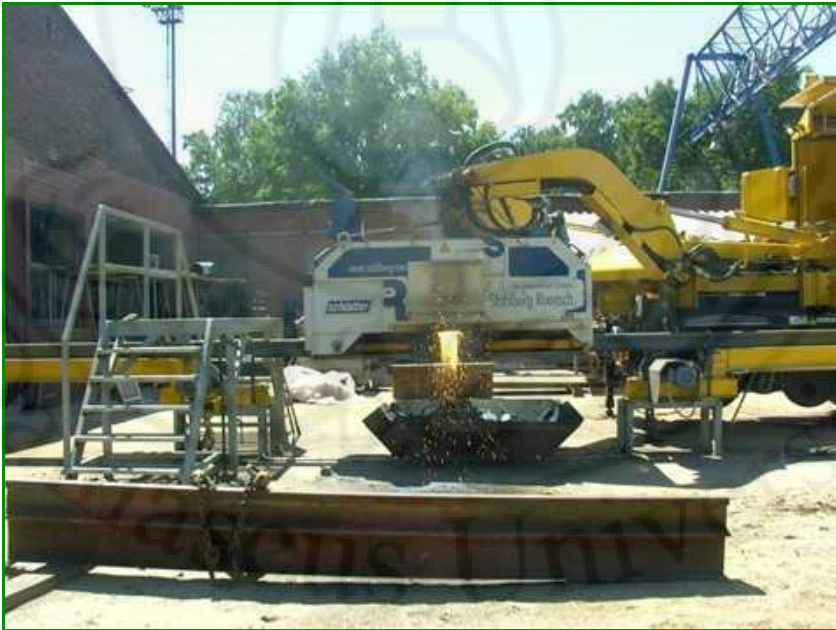
الشكل (3-45) اللحام الكهربائي
