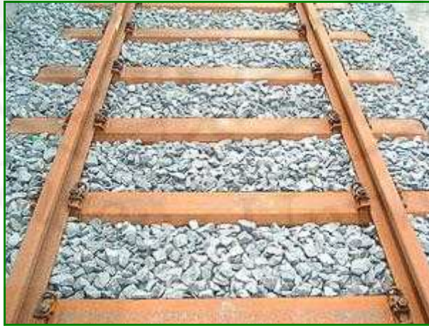
الشكل (3-15) نموذج للعارضة المعدنية ذات الشكل SW 9
