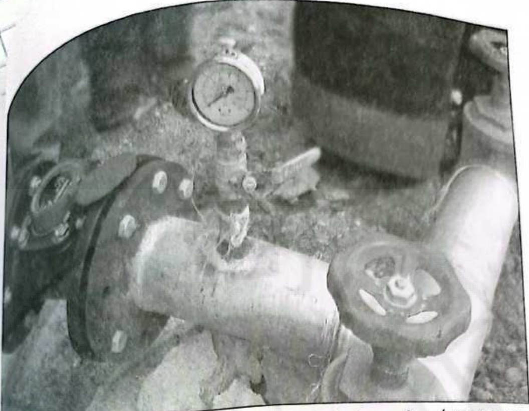
شكل (8-23): أنبوب فرعي يعمل على توصيل المياه بين أنبوب تحت رئيسي وشبكة أنابيب السقاية ضمن مقسم الري. مزود في بداته بمقياس للضغط وعداد مياه
