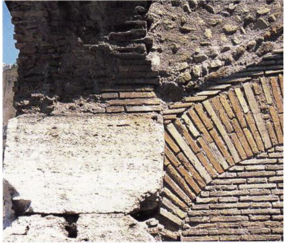
الصورة رقم (١٧) مداميك من الحجارة التي استخدمت بالكولوسيوم ١
