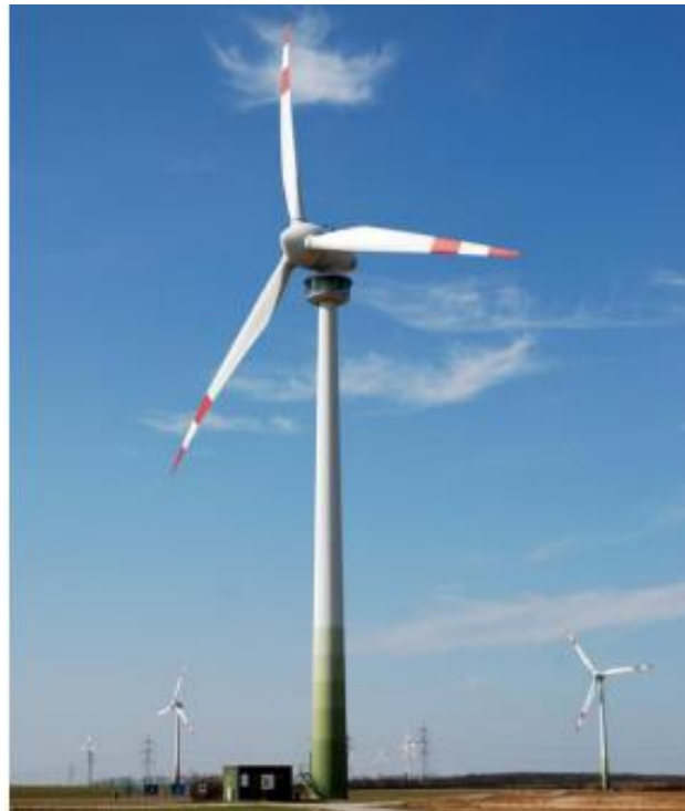
الشكل (2-3): يبين توربينات الرياح ذات المحور الأفقي (HAWT)
