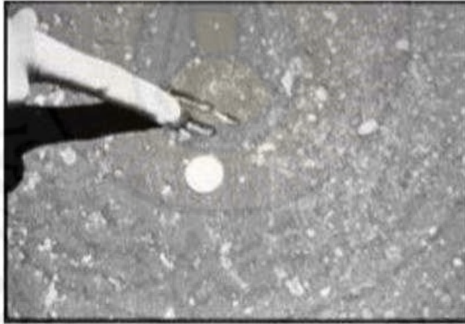
الشكل رقم (9) نزف الاسفلت
