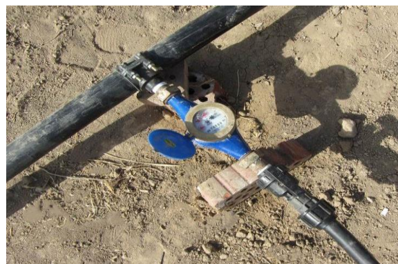
الشكل (3-11): عداد المياه في بداية الشبكة
