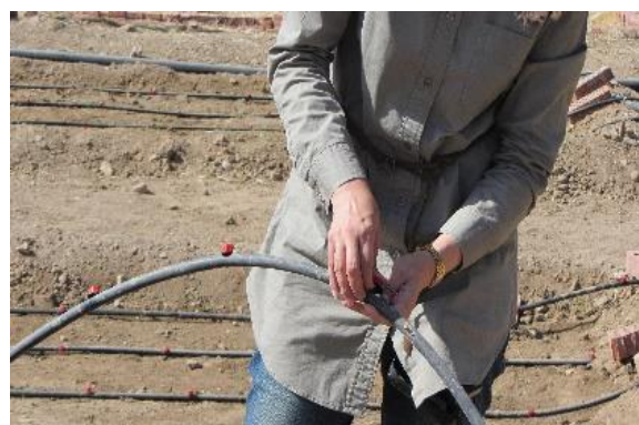
الشكل (3-9): تركيب النقاطات الخارجية
