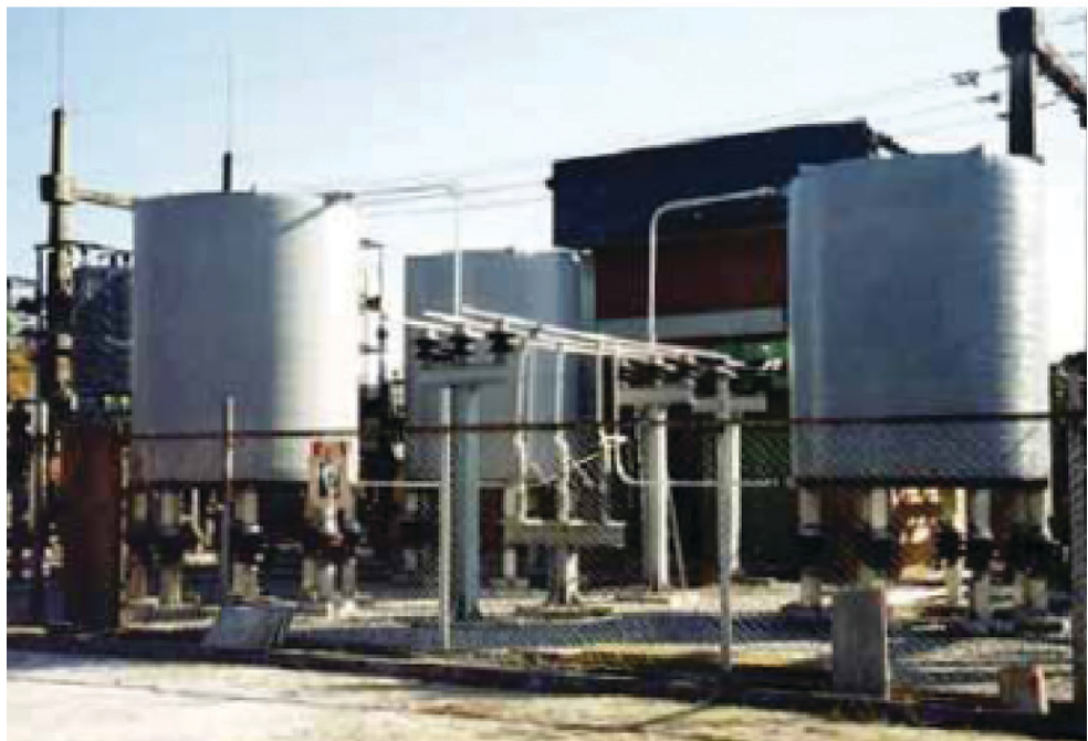
الشكل رقم ( 8 - 6 ) ملفات تعويض عرضاني أحادية الطور تبريد بالهواء مستخدمة في ألمانيا
