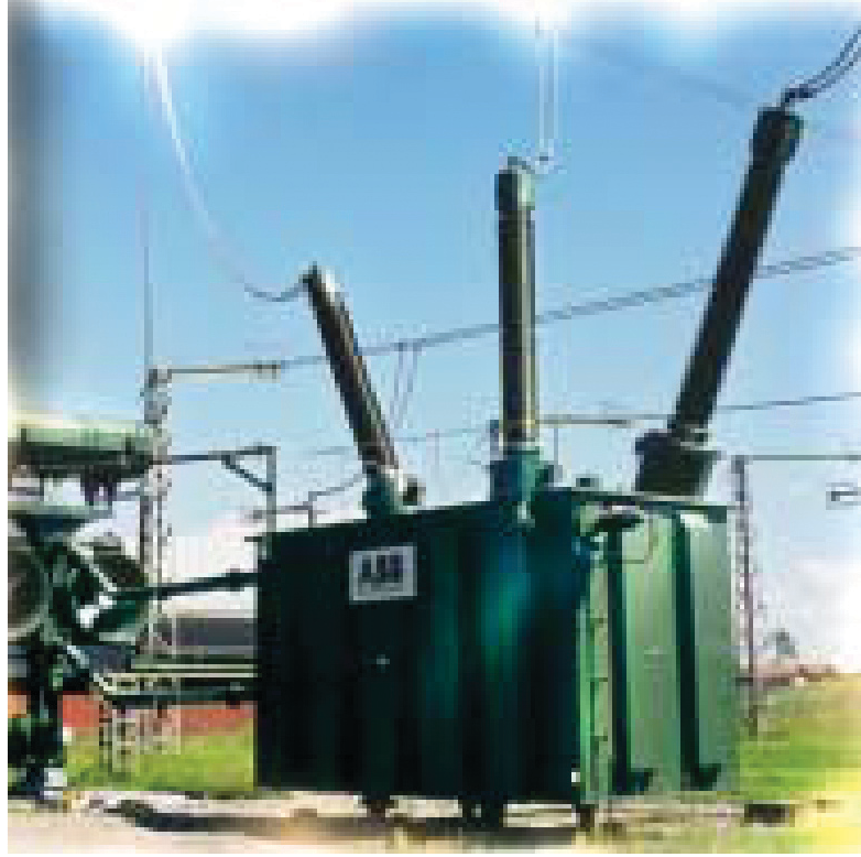
الشكل رقم ( 8 - 7 ) ملفات تعويض عرضاني ثلاثية الطور تبريد بالزيت
