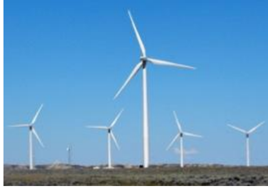
الشكل (2-4) العنفات الريحية أفقية المحور ثلاثية الشفرة
