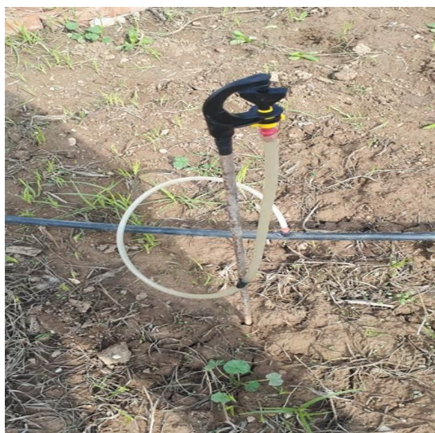
الشكل رقم (5-6-7) تركيب شبكة الري بالرش
