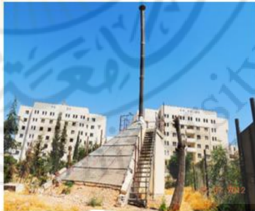
الشكل (6.2.5) نظام مدخنة شمسية مائلة
