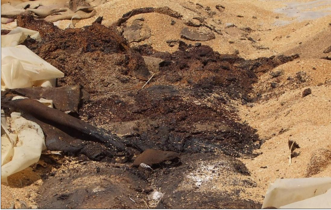
الشكل (6) اللواصق والأرضيات المتعفنة نتيجة تسرب مياه الأمطار والرطوبة إلى أرضية الكدس
