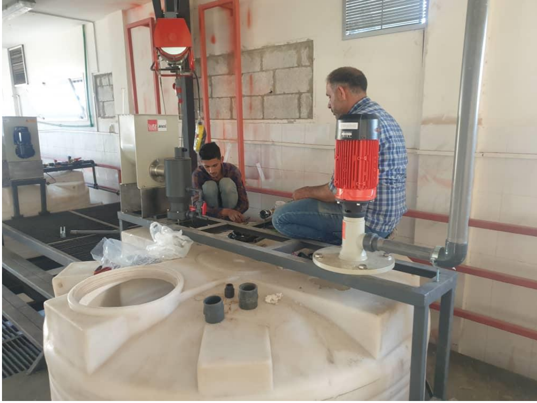
الشكل (4-11) أنبوب الضخ لمضخة النقل
