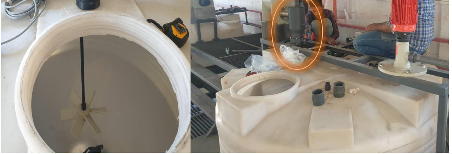
الشكل (4-10) التثبيت الرأسي للخلاط ضمن خزان التحضير
