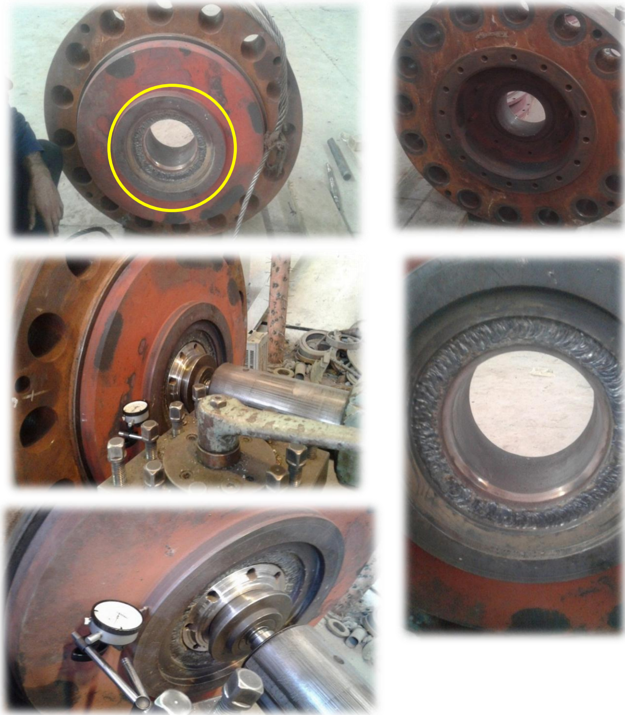
الشكل (21.4) إجراء عملية اللحام للترس ومن ثم إجراء عملية تسوية للسطح الملحوم
