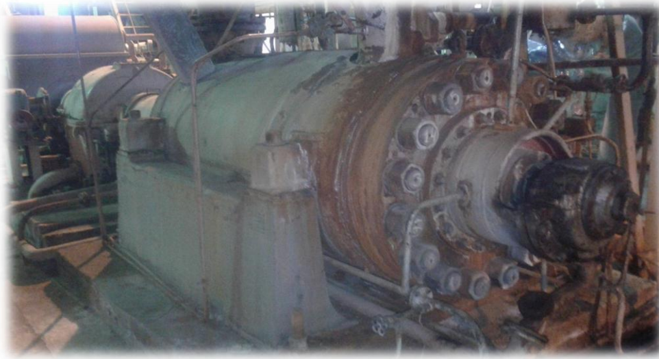
الشكل (3.4) مضخة تغذية المرجل البخاري (عينة الدراسة)
