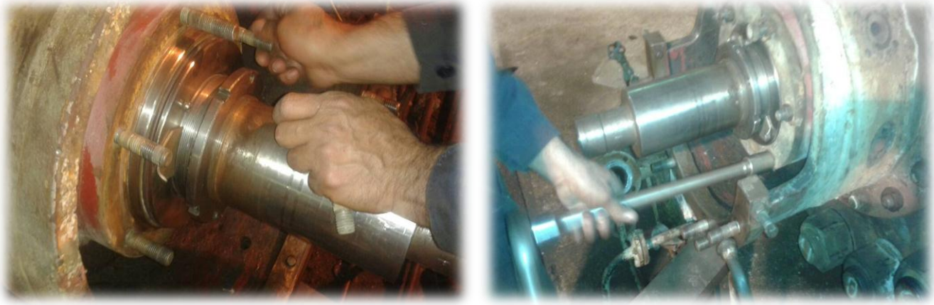
الشكل (59.4) تركيب حلقة أمامية في مقدمة قاعدة كرسي المحور وتثبيتها بالصواميل
