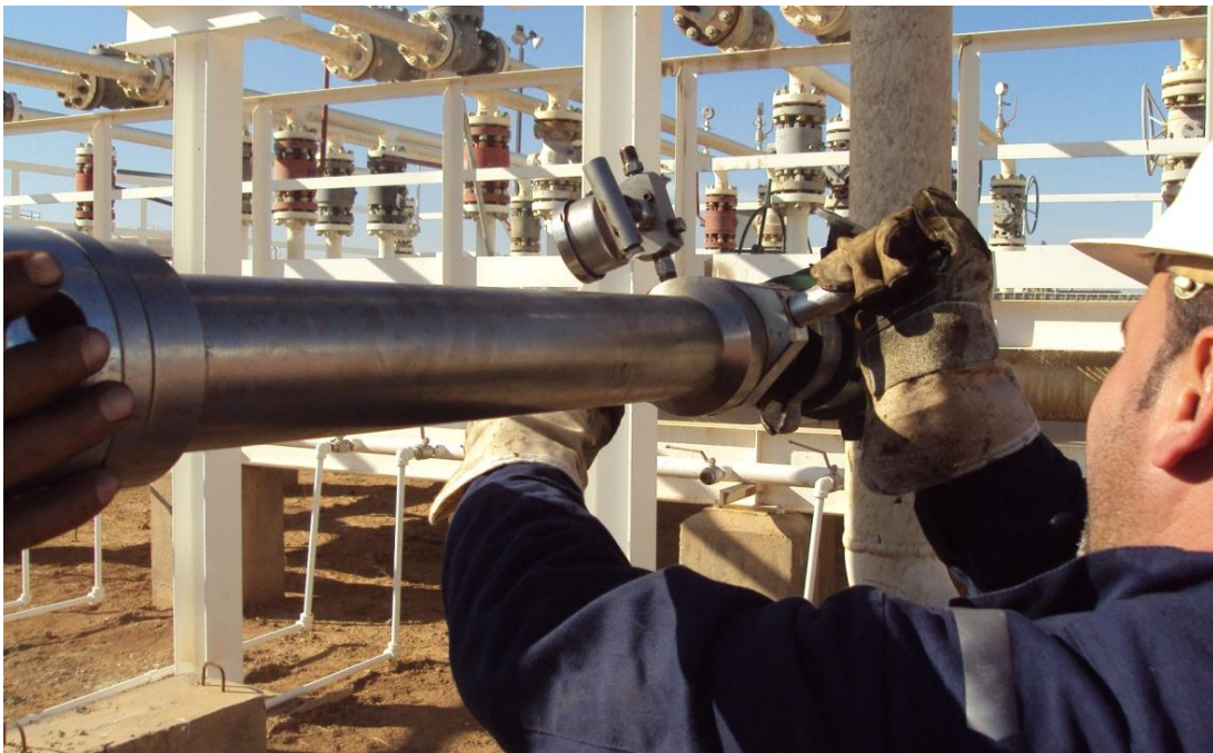
الشكل (8.3) تركيب الجهاز على خط النفط وفك الصامولة.
