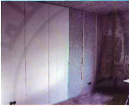
الشكل (٤٤-١) على اليسار يبين غرفة فيها الجدار الجانبي ويظهر عليه طبقات العزل الصوتي المختلفة. والشكل على اليمين يبين الجدار المعزول بشكل تخطيطي مفصل ١- الجدار الأساسي. ٢- مادة عازلة (حشوة) عازلة. ٣- العوارض الخشبية. ٤- ألواح الجص والكرتون العازلة. ٥- طبقة طينة.
