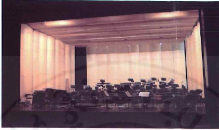
الشكل (٣٦-١) قاعة للاستخدامات الموسيقية وتلاحظ فيها السطوح المحدبة الملساء على الجدران والسقف لانتشار أفضل ومناسب للصوت
