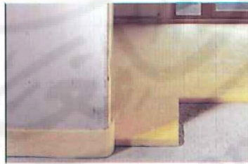
الشكل (٤٥-١) عزل الأرض عن طريق فرش وتركيب ألواح من مادة اللباد العازل للصوت
