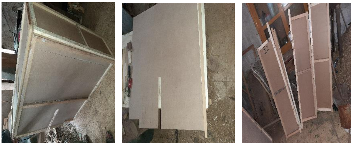
الصورة (18) مراحل تنفيذ الهيكل الخشبي
