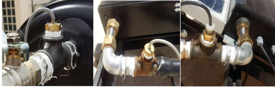
الشكل (3-9) حساسات درجة الحرارة
