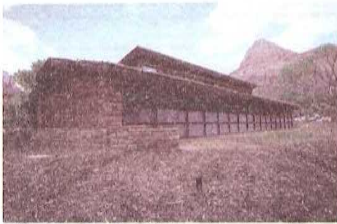
الصورة (68) مركز زوار يرى فيه جدار ترومب ونوافذ علوية في الجزء المرفوع (الكسب المباشر)
