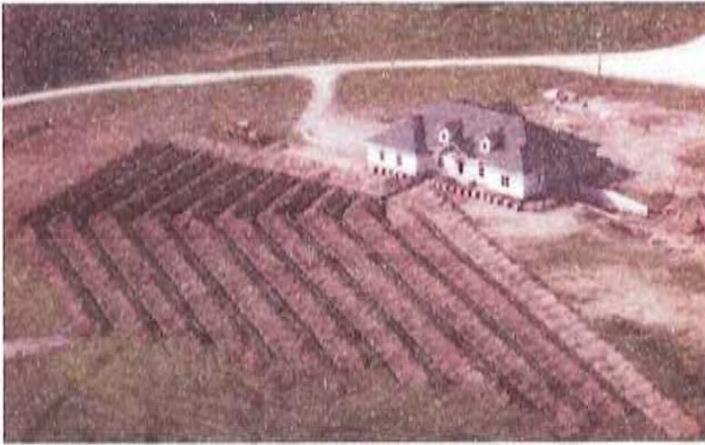
الصورة (83) صورة جوية تظهر التحضيرات للحفر الخاصة بالحلقات أو الدارات المغلقة للاستفادة مضخات التسخين للموارد الأرضية مجهزة للربط مع منزل جديد
