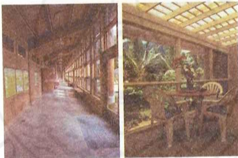
الصورة (60) النوافذ على طول الممر في اليسار تسمح لحركة الهواء عبر القاعات الصفية إلى اليمين التهوية العابرة حول القناء الأخضر لتأمين تعايش داخلي وخارجي
