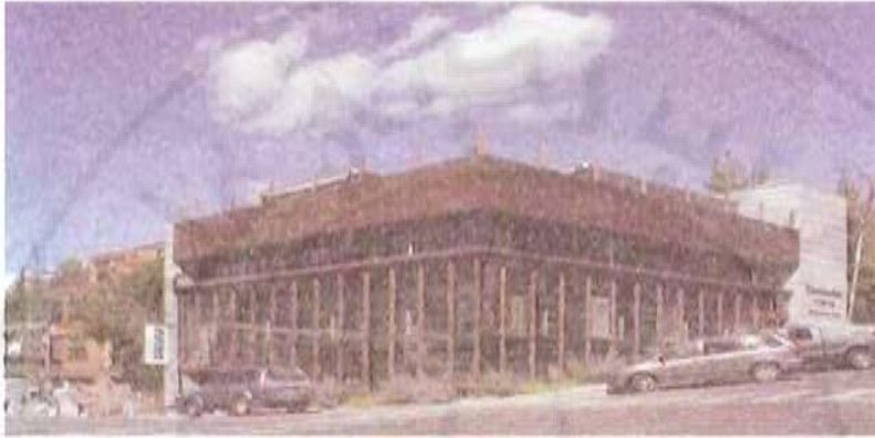
الصورة (66) التخزين الحراري (ترومب) جدران خلف الواجهات المزججة (سوبر ماركت) لتجميع الطاقة الشمسية
