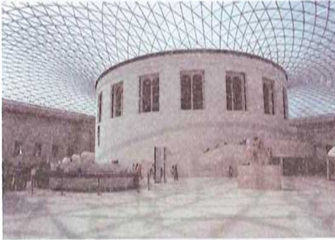
الصورة (33) مظلة زجاجية فوق ساحة Grest Court ممتدة بين الأقسام القديمة والأقسام الحديثة لمبنى British Museum في London, UK. مزودة كامل الإضاءة النهارية كإضاءة علوية
