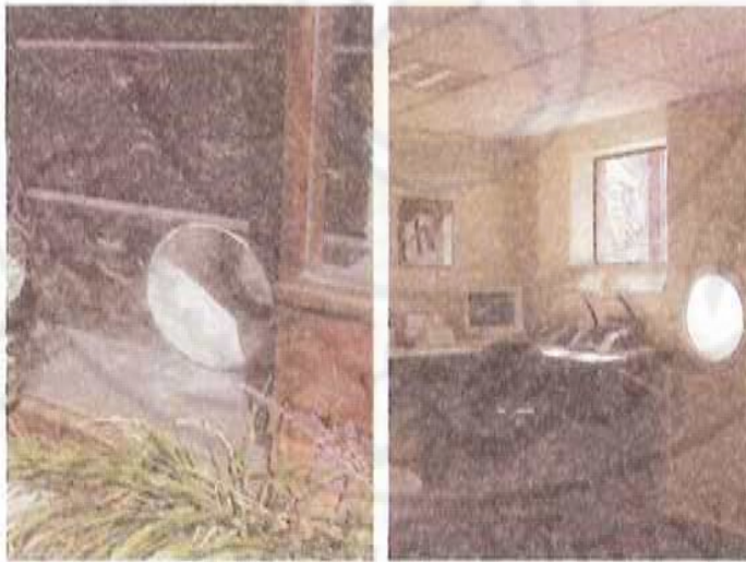
الصورة (67) مدخل هواء دائري مفتوح في أسفل جدار ترومب (الصورة اليسرى) يجلب الهواء الساخن نحو الأعلى من خلال فجوات في مكتب بالطابق الثاني إلى مخرج هواء دائري (اليمنى)
