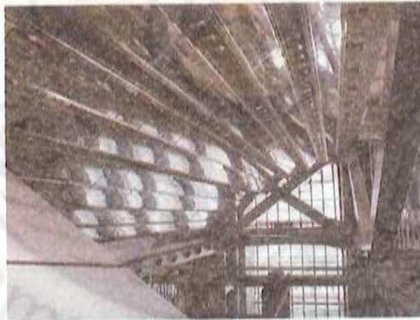
الصورة (40) الانعكاسات البراقة (طريقة أخرى للتفكير حول رفوف الإضاءة) في قمة القاعة الرئيسية في توجه الإضاءة النهارية الى الأرضية Hong Kong Shanghai Bank
