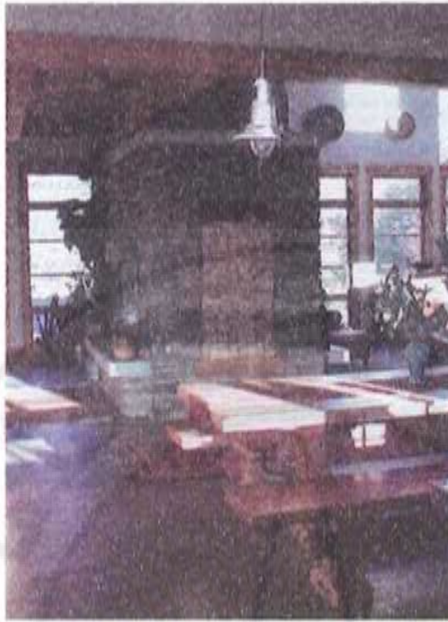
الصورة (62) تمتص الأرضية البيتونية والمدفأة الحجرية الأشعة الشمسية الواردة من النافذة وفتحات الضوء السماوية في المنزل (المصدر Bruce Haglund)
