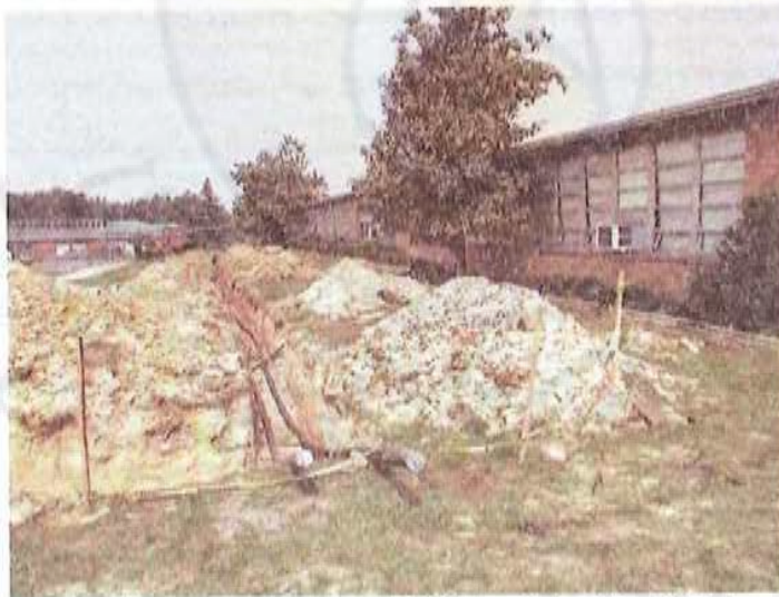
الصورة (82) حلقات (دارات مغلقة) للاستفادة من الموارد الأرضية توضع على عمق 0.9 محمية في خندق حول مدرسة
