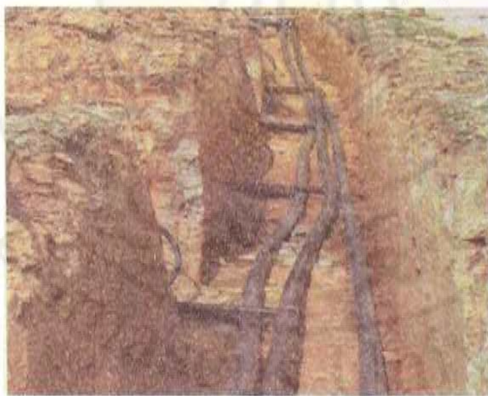
الصورة (80) استخدام حلقات أرضية أفقية بشكل كبير
