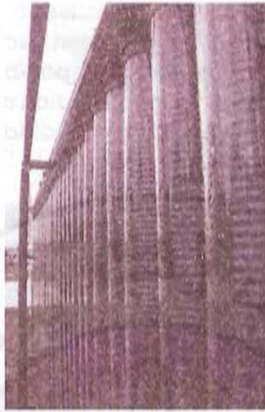
الصورة (74) مجمعات انابيب شمسية مفرغة
