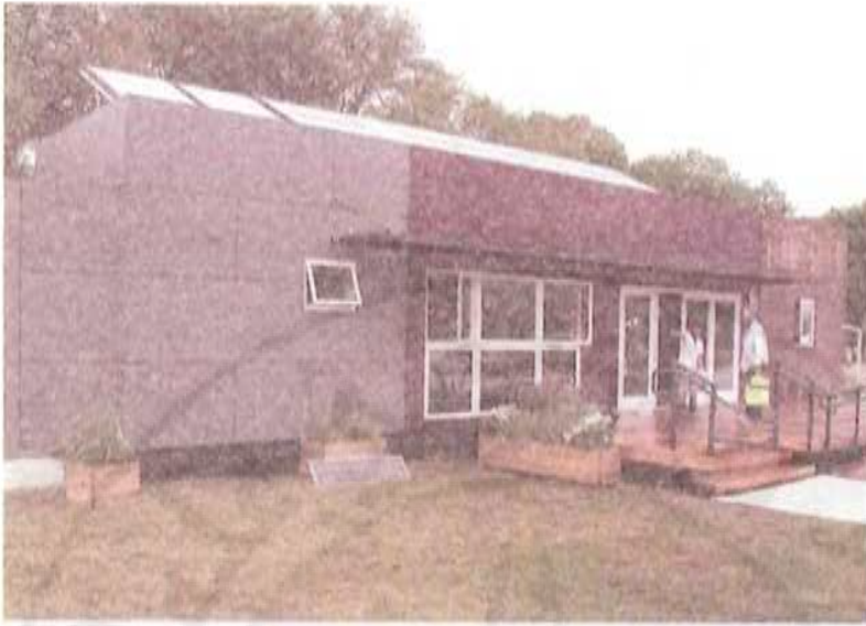
الصورة (79) توضح مجمع تسخين شمسي على شكل ألواح أفقية (لوحين في الأعلى يساراً) تتكامل بشكل جيد مع نموذج لتوليد الكهرباء من الشمس (خلايا ضوئية مصفوفة إلى اليمين على السطح)
