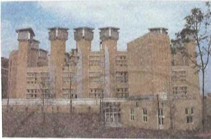
الصورة (58) أبراج التهوية الساكنة لإخراج الهواء الساخن في مكتبة لانكستر بريطانية
