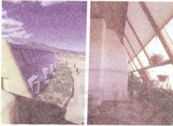
الصورة (64) مثال تقليدي للفتحات الشمسية والتحكم بها والكتل الحرارية في بيت سكني في نيو مكسيكو
