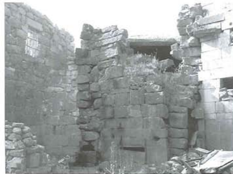
هـ- الواجهة الشمالية، (الغرفة 105/005).
