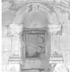
65- نوى، مشكاة داخل غرفة الخجلة 004 في المسكن رقم (8).
