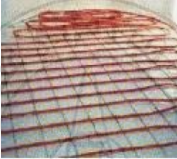
شكل (5-6) يوضح وحدة تدفئة أرضية بالإشعاع
